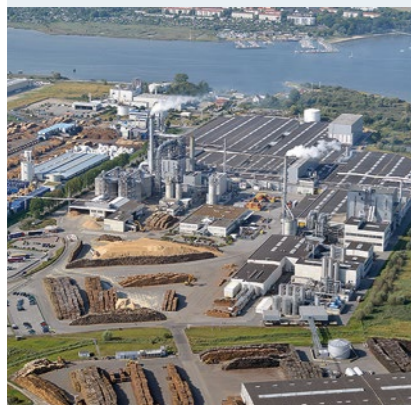
Das 900.000 m 2 große Gelände in Wismar ist per Straße, Schiene und Seeweg angebunden.
