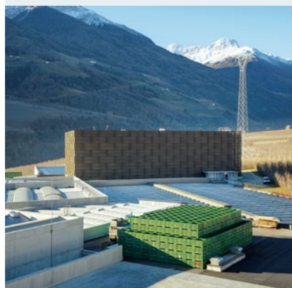
Das neue Hochregallager dient als Puffer zwischen CA-Zellen, Sortierung und Verpackung.
