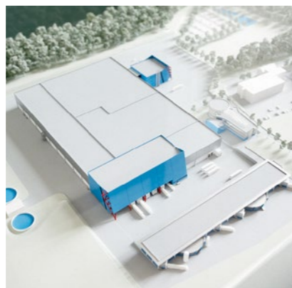
Modell der neuen, 25.000 m² großen Produktionshalle in Heilsbronn. Das Hochregallager befindet sich in dem blau gefärbten Gebäudeteil im Vordergrund.
