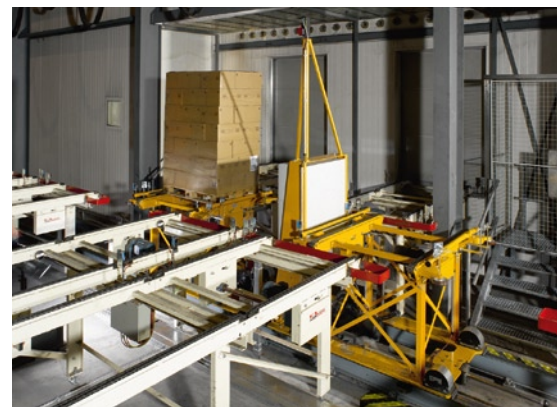
Der neue, schnellere Doppel-Verschiebewagen behebt 2007 ein Nadelöhr in der Fördertechnik und läuft seither dank vorbeugender Wartung reparaturfrei.
