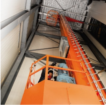
Zwölf-Stunden-Schicht bei -28^{\circ}\text{C} : Die drei automatischen Regalbediengeräte werden im Wartungsbahnhof am Ende des Wechselgangs umgebaut.
