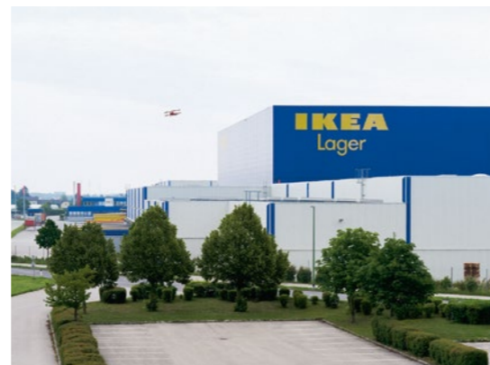
Das Hochregallager liegt in der Einflugschneise des Welsener Flughafens. Das Szenario einer Aufstockung der Halle scheidet nach längeren Verhandlungen aus.
